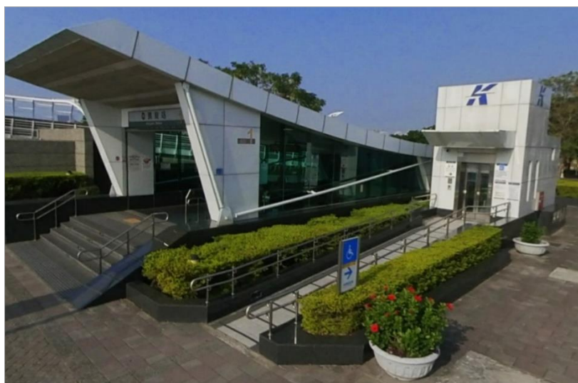
圖 肆-10 捷運凱旋站1號出入口地面層無障礙設施(Google街景)
